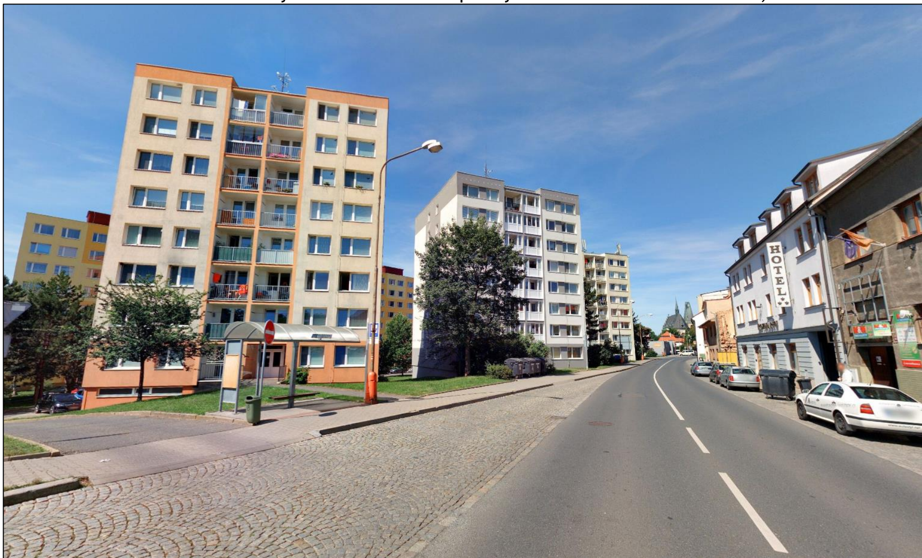
Obr. 20: Fotodokumentace zástavby v okolí kritického místa priority I ve městě Rakovník - ulice Pražská, komunikace II/227
