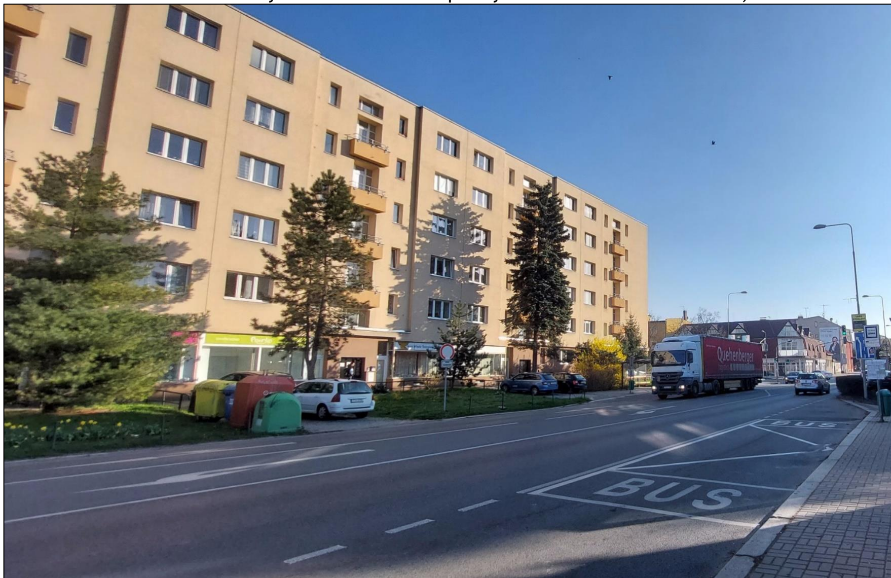
Obr. 12: Fotodokumentace zástavby v okolí kritického místa priority I ve městě Kolín - ulice Ovčárecká, komunikace II/125
