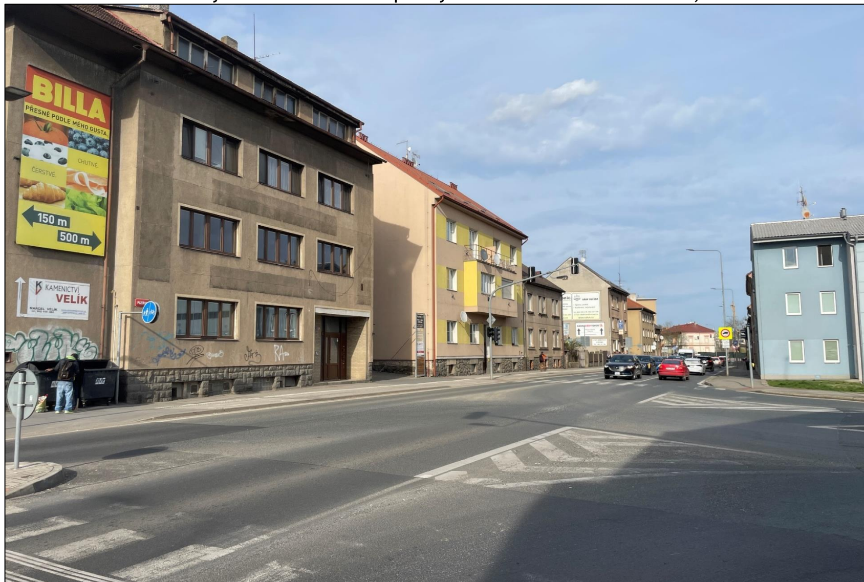
Obr. 10: Fotodokumentace zástavby v okolí kritického místa priority I ve městě Beroun - ulice Plzeňská, komunikace II/605 a III/11533
