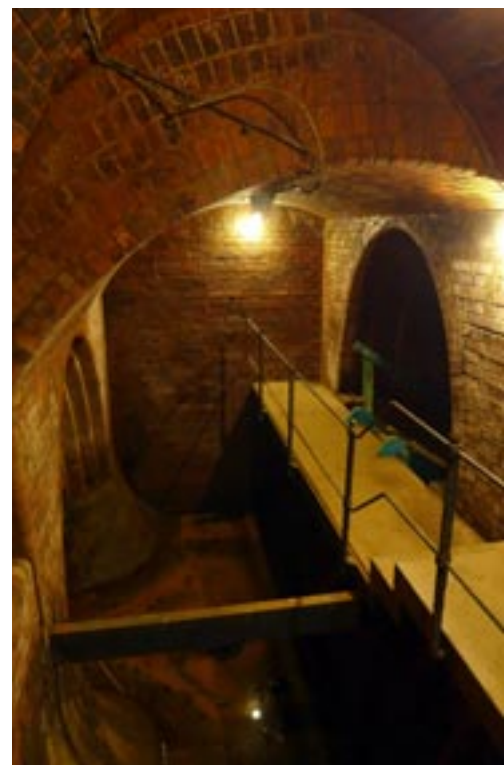
Mistrná sestava kleneb v okraji odpadní galerie. Vpravo vyústění obtokového kanálu po straně usazovacích nádrží, vlevo ústí odtokového kanálu, kterým již vyčištěné vody postupovaly do shybky pod podbabským plavebním kanálem a pod Císařským ostrovem, aby odtékaly do Vltavy.
