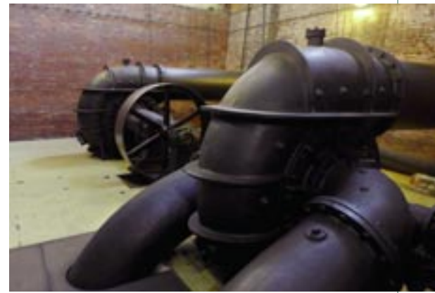
Odstředivá povodňová čerpadla na dolní etáži hlavní strojovny. Chybějí řemeny pro pohon od transmise.
