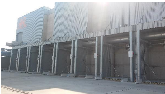
Vsypová vrata do zásobníku odpadů
