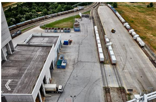
Přesun kontejnerů z železnice do bunkru nákladním vozidlem
